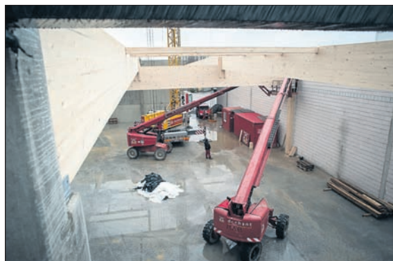
Die neue Halle ist inzwischen so gut wie fertig.
